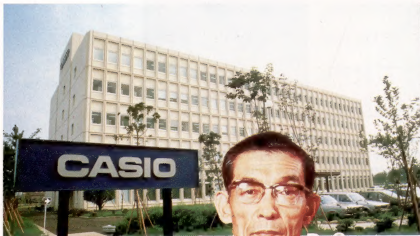
Le centre de recherche et de développement de Casio, à Tokyo
